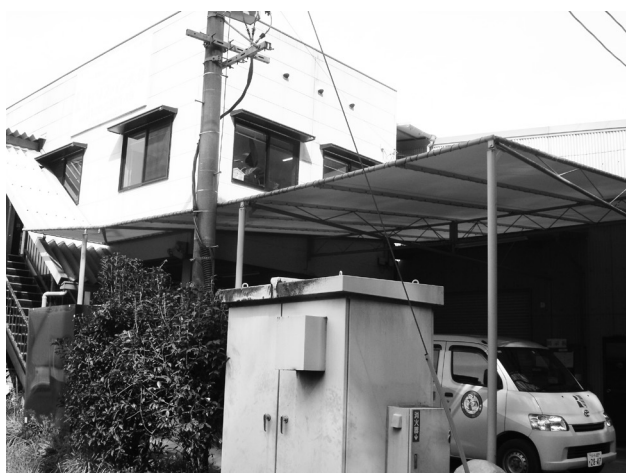
事務所棟（第1工場の2階部分）
